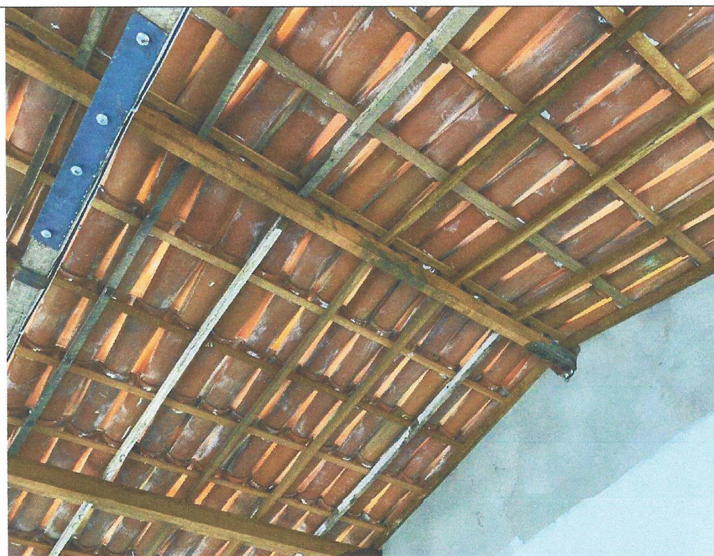
EXECUÇÃO DE TELHADO COM APROVEITAMENTO DE TERÇAS E CAIBROS E TESOURA.
