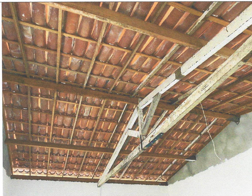
EXECUÇÃO DE TELHADO COM APROVEITAMENTO DE TELHAS
