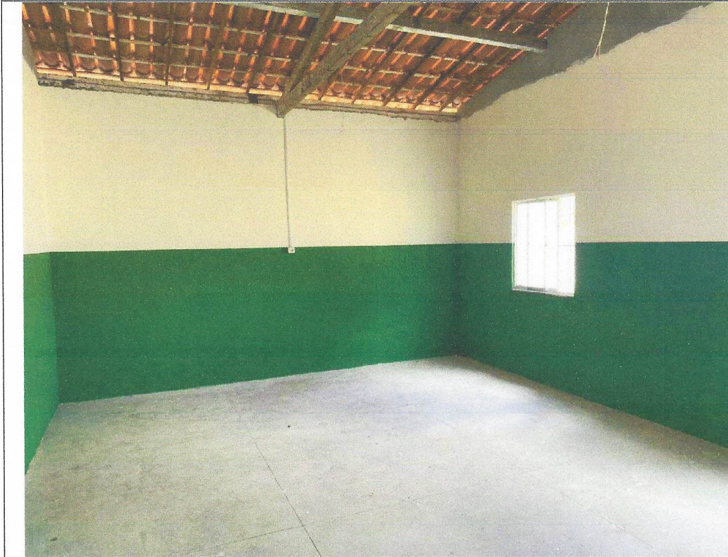
EXECUÇÃO DE PINTURA
